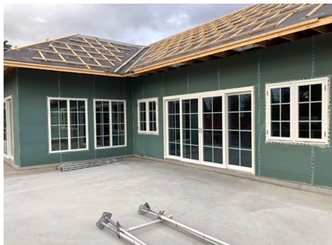
Eksempel på vegg komplettert med tape/vindspærre
