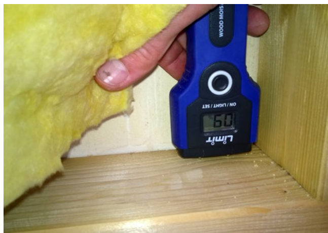
Eksempel på fuktmåling
