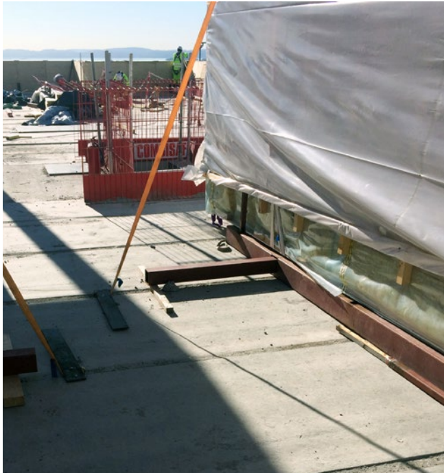
Eksempel på sikrede elementer ved lagring.
