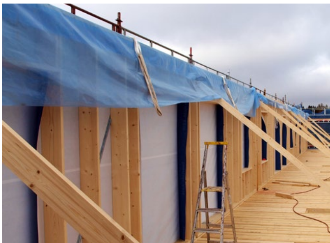
Eksempel på provisorisk beskyttelse mot fuktinntrenging
